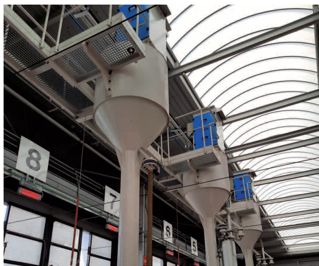
■ Figura 3 ■ (a) Tolvas equipadas con dispositivos de carga y (b) Operación de carga de arena de una UT de Metro Bilbao
