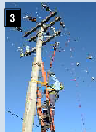
1. Verificación del buen contacto de los morsetos / 2. El carretel del cable de la puesta a tierra debe estar absolutamente desarrollado / 3. El cable debe estar separado del cuerpo del operario.
