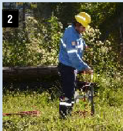
1. Verificación del buen contacto de los morsetos / 2. El carretel del cable de la puesta a tierra debe estar absolutamente desarrollado / 3. El cable debe estar separado del cuerpo del operario.
